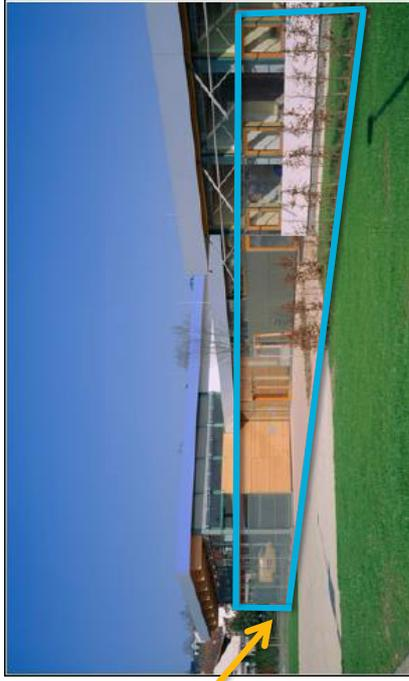
Además no cuenta con muros perimetrales, el cerramiento está compuesto de rejas metálicas, las cuales permiten permeabilidad.
