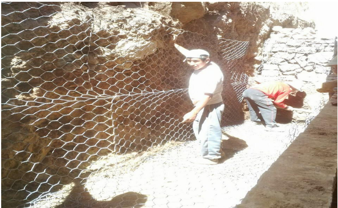
6.- Sujetamos Todos las Partes de los Gaviones con Alambre galvanizado
