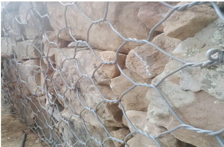
Figura 11. Material llenado en canastas
