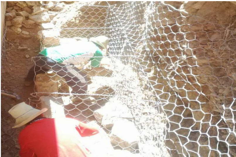
Figura 16. Empleo del geotextil gaviones, Fuente: imagen propia
