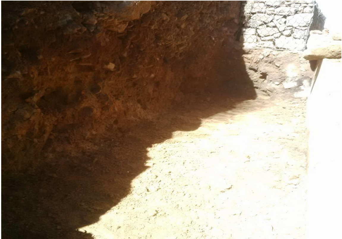
5.- Instalación de las Mallas Gaviones
