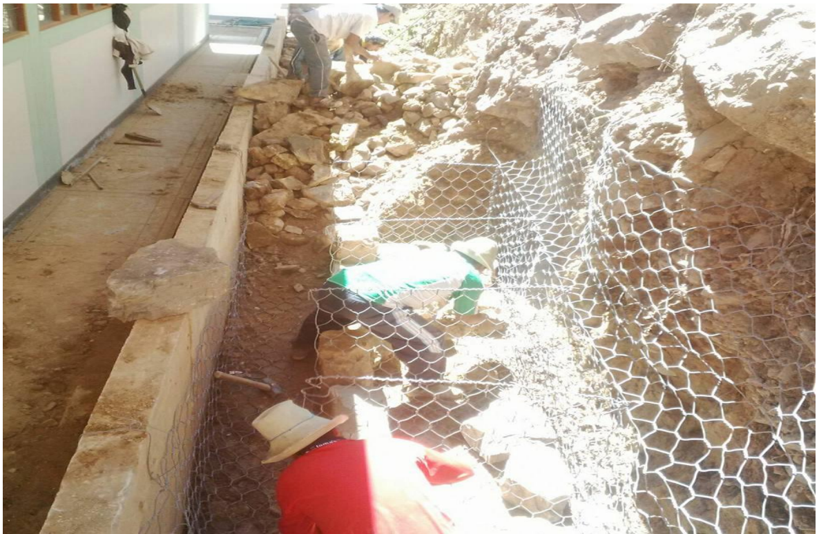
8.- Llenamos los cajones del gavión hexagonal
