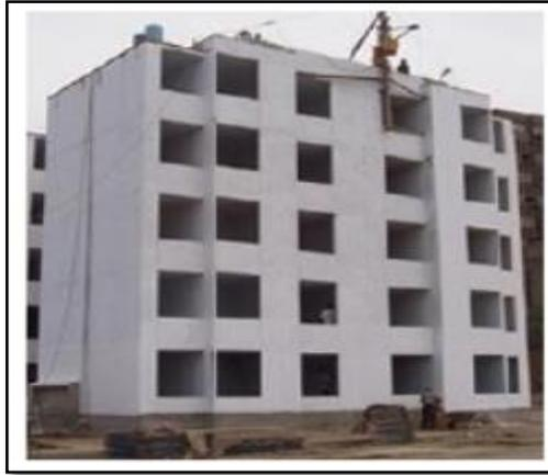
Figura 13: Sistema estructural de muros resistente en un edificio de viviendas.
