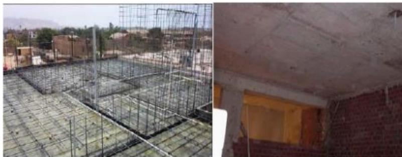
Figura 11: Losas macizas con muros en sus cuatro bordes.
