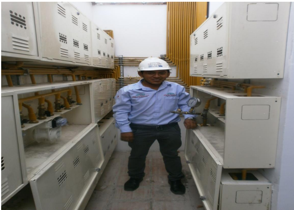
Figura 22. Centro de medición (Gabinete)
