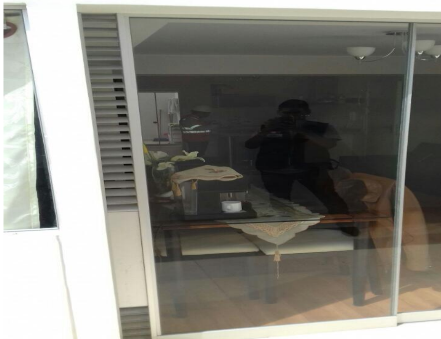
Figura 25. Tipos de rejillas instaladas en los departamentos.
