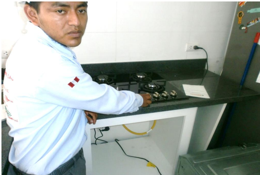
Figura 24. Artefactos de cocina instalados en los departamentos.
