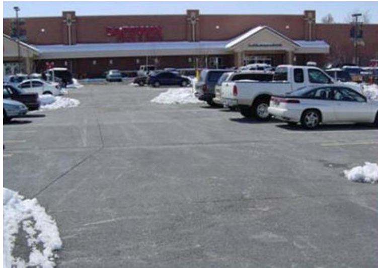
Figura 1: Superficie con concreto permeable
