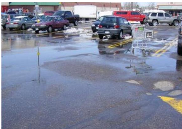
Figura 2: Superficie con asfalto
