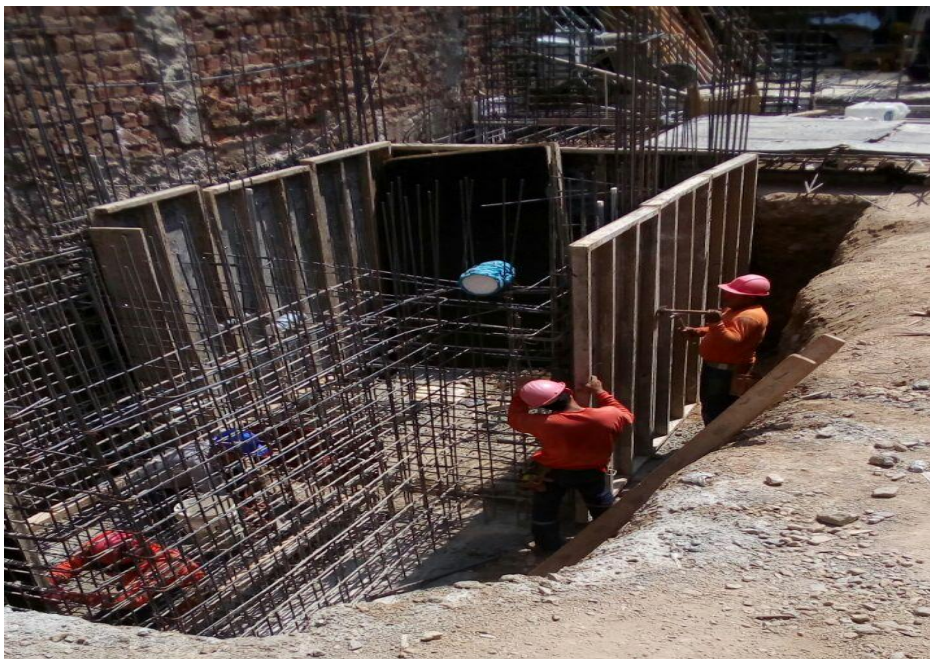
Foto 02: habilitación de acero y encofrado
