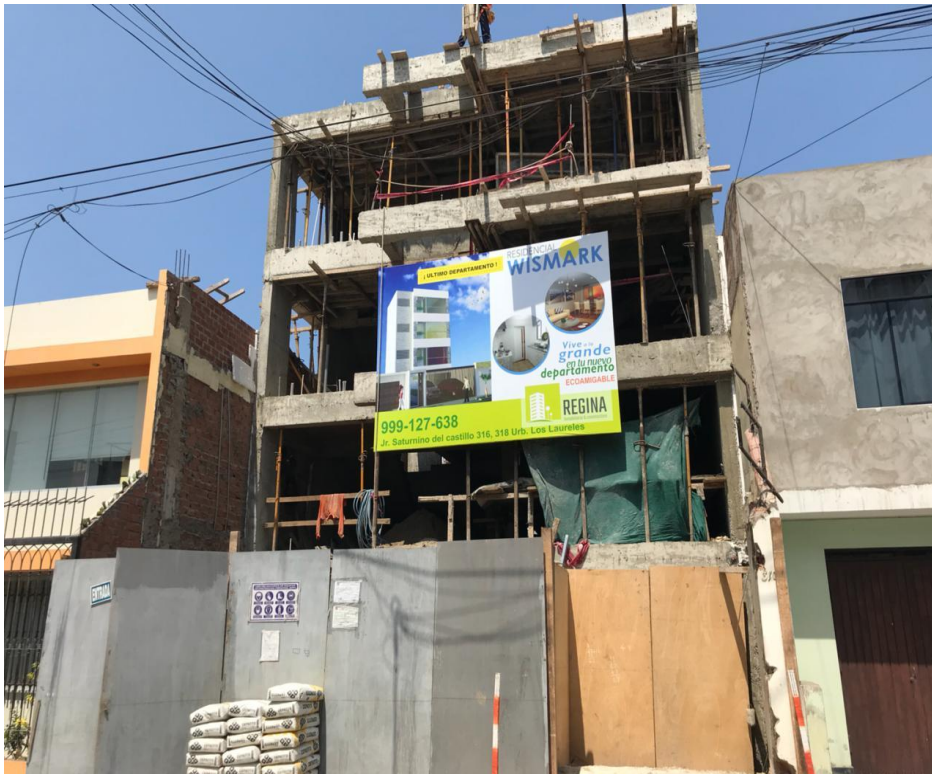
Foto 11: terminado de estructura
