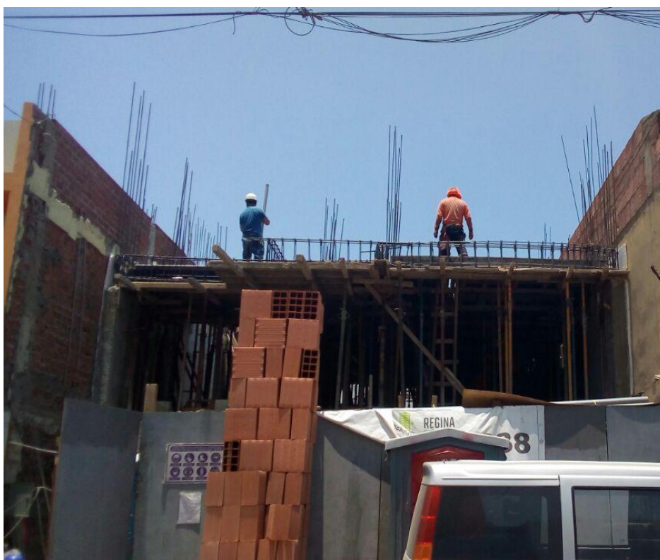
Foto 06: Encofrado de vigas y losas
