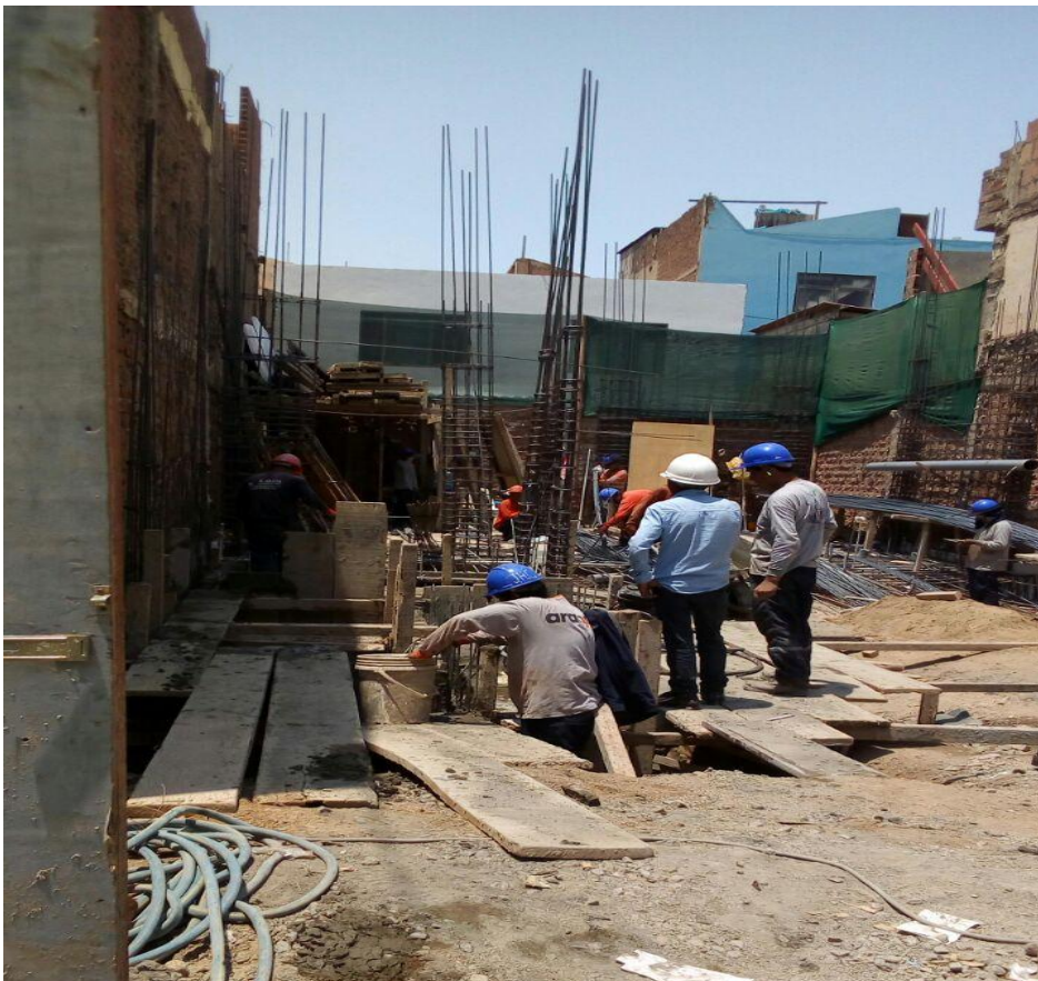
Foto 04: habilitación de acero en placas y encofrado
