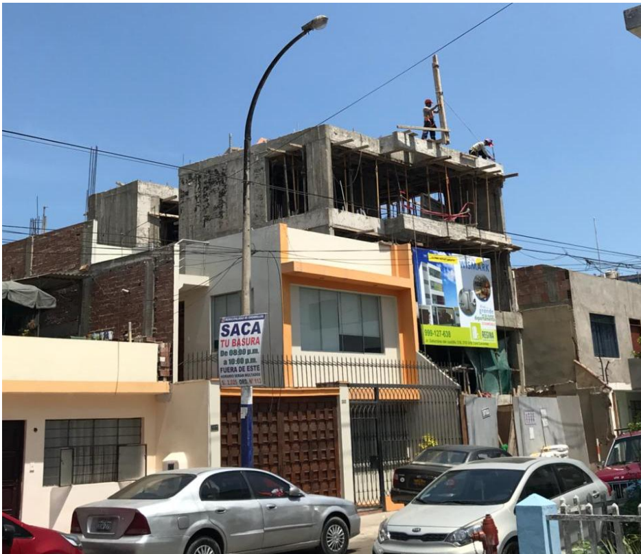
Foto 10: terminado de estructura
