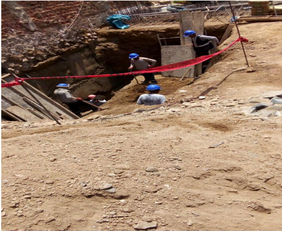
Foto 01 : Excavacion de zanjas
