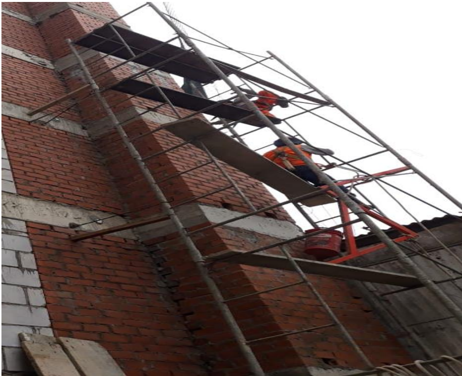
Foto 09: Construcción de muros de albañilería confinada
