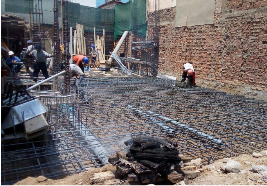
Foto 03: habilitación de acero en platea de cimentacion
