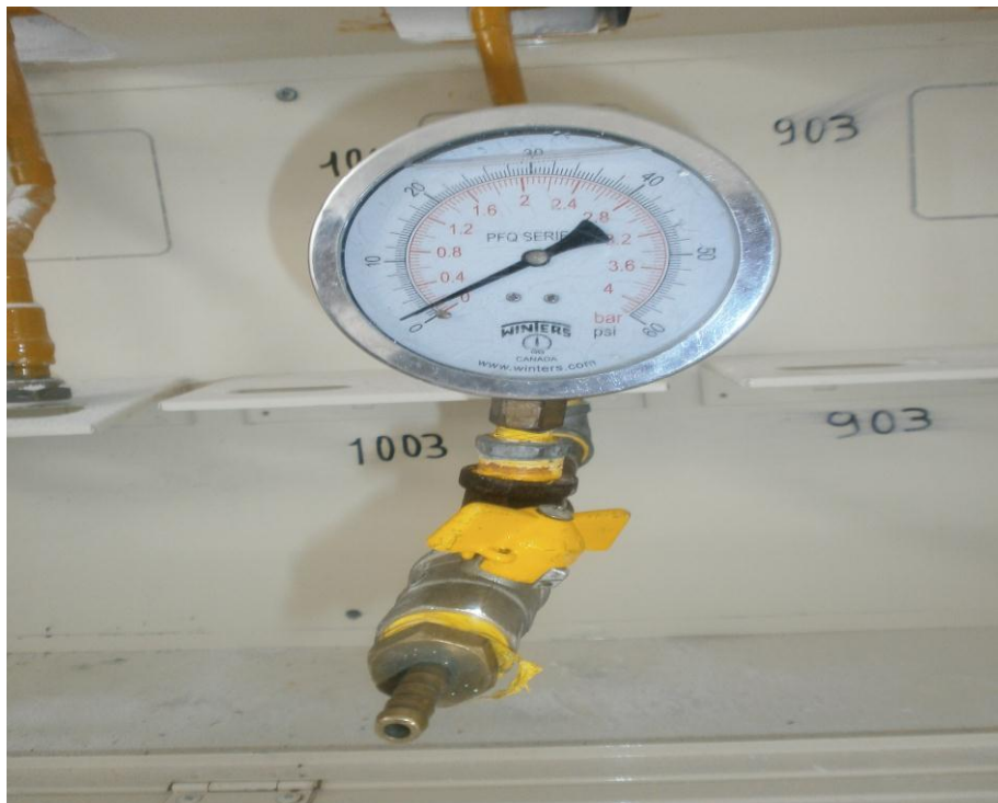
Medición de presión con manómetro.
