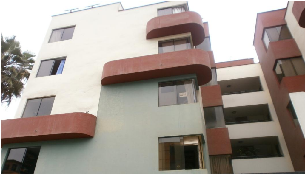
Vista del edificio multifamiliar, para plantear el recorrido de la montante.
