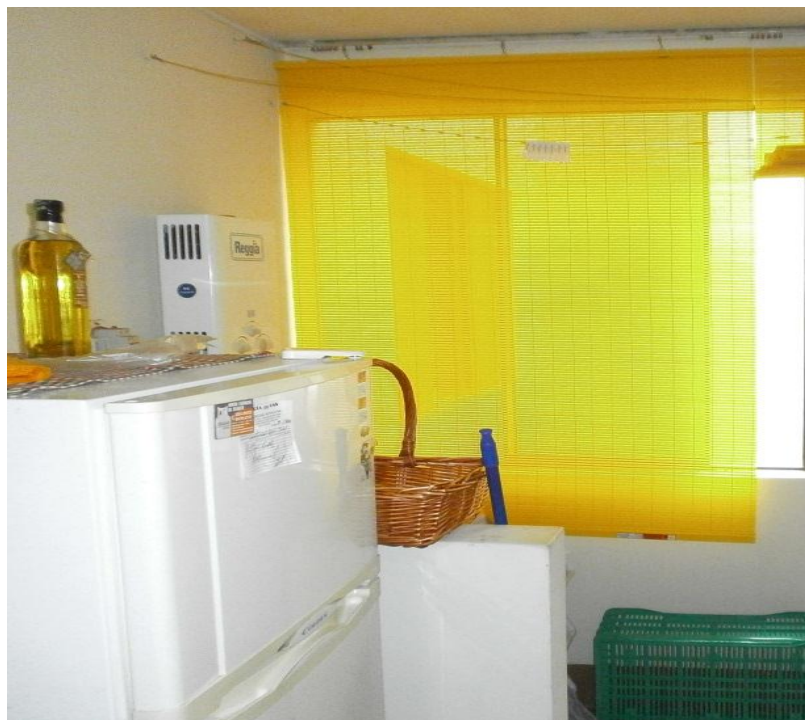
Gasodomicos (terma) de los departamentos del edificio multifamiliar.
