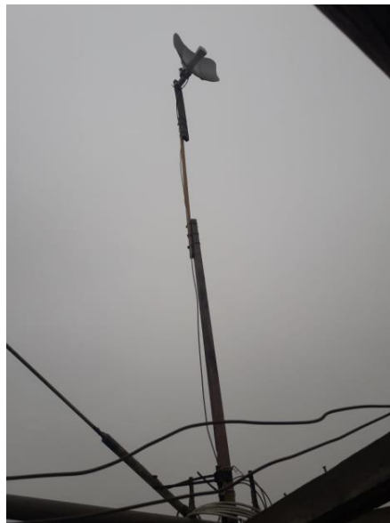
Figura 61: Después de la instalación de antena receptora
