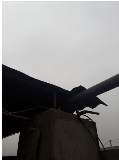
Figura 60: Antes de la instalación de antena receptora
