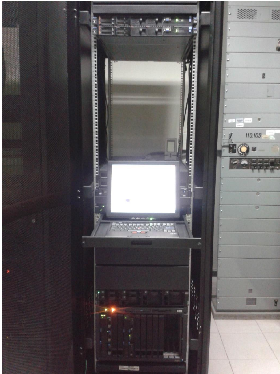
Figura 98: Consola de administración de los Servidores de la Empresa de Generación Eléctrica del Sur S.A.
