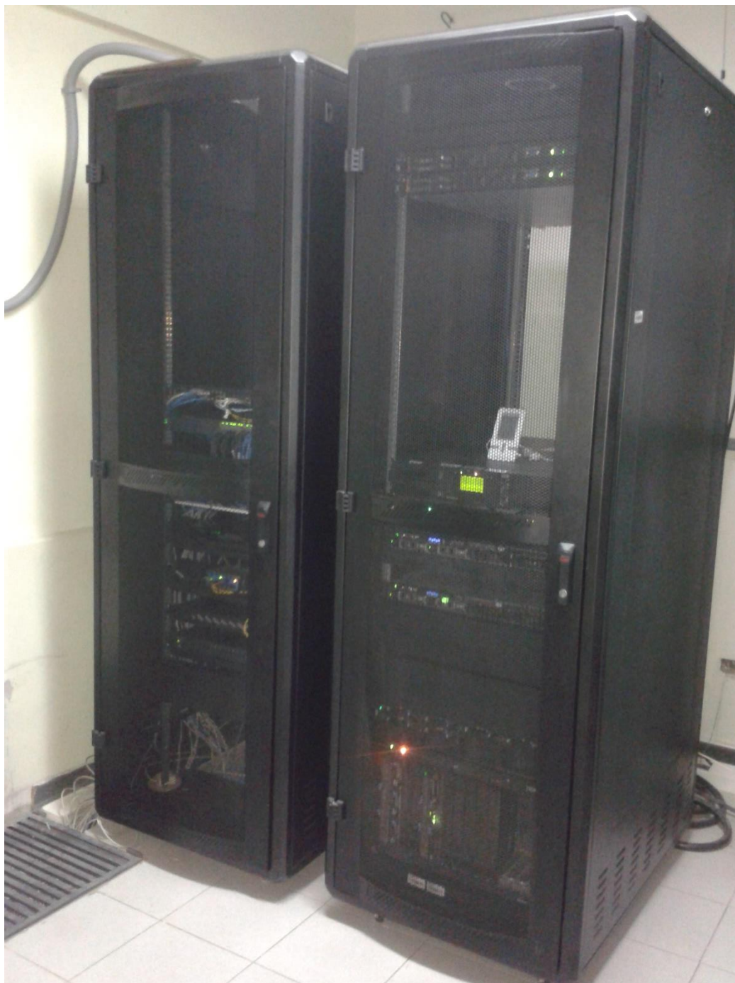
Figura 97: Sala de Servidores de la Empresa de Generación Eléctrica del Sur S.A.
