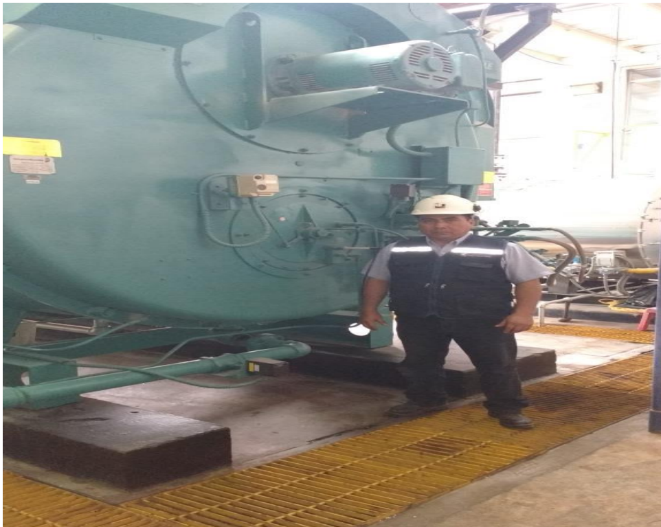
CALDERO EN SERVICIO
