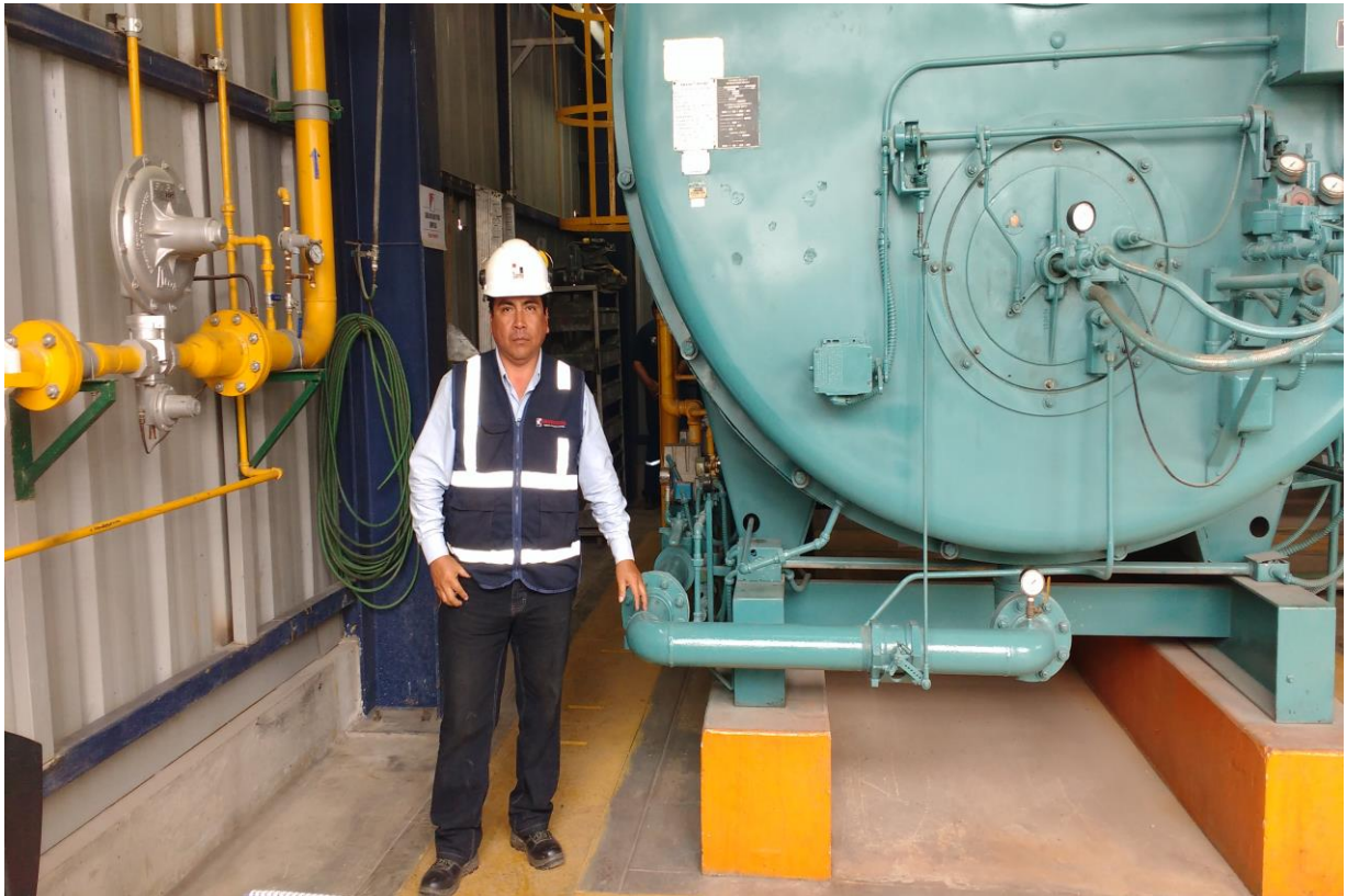
Figura 05. Evaluación del caldero piro tubular de 100 BHP
