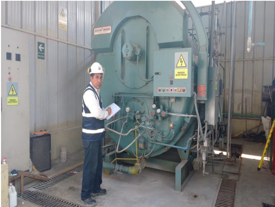
TOMA DE DATOS DESPUES DEL MANTENIMIENTO
