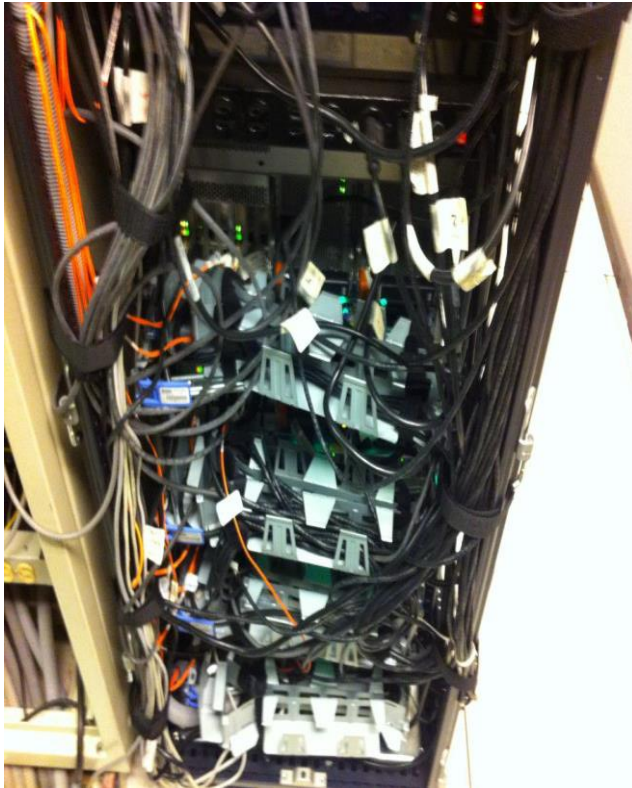
Figura 2. Gabinete totalmente lleno, no permite la correcta refrigeración de los equipos.
