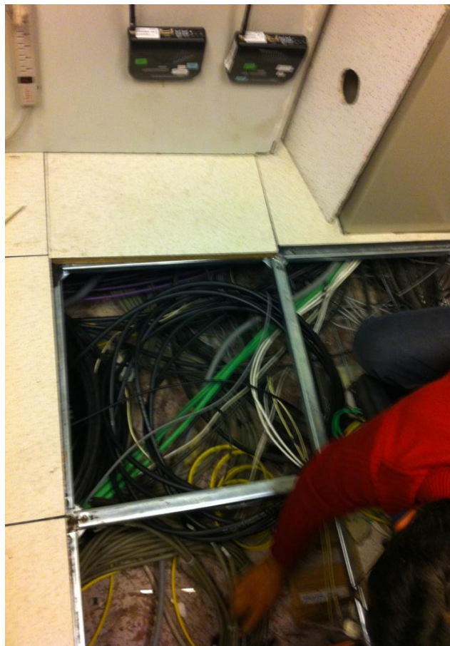
Figura 6. Desorden del cableado eléctrico en el falso piso
