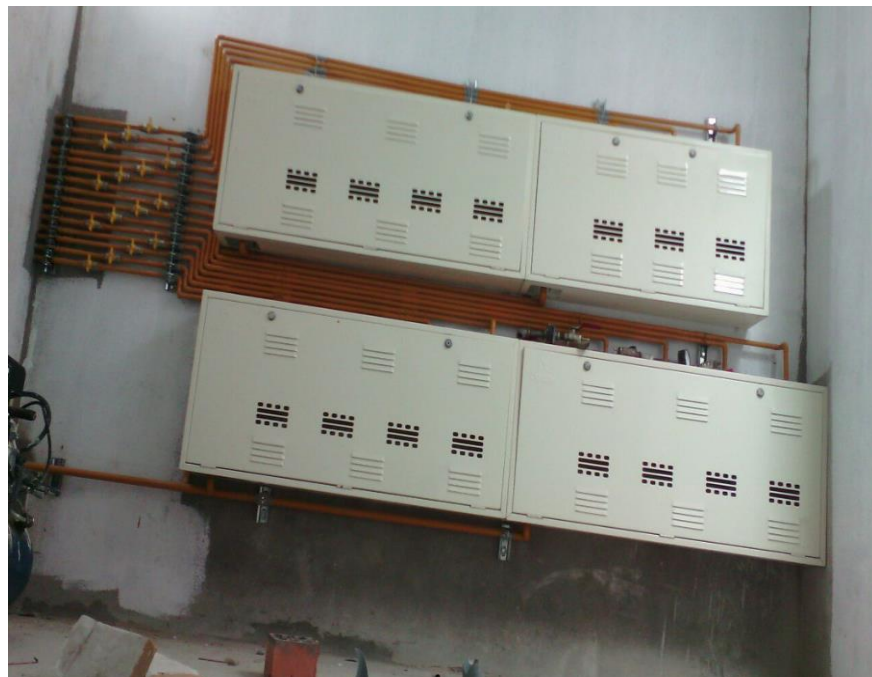
Centros de medición de cada departamento. Es aquí donde se registra el consumo de cada usuario de gas natural y donde se toma la lectura para emitir los recibos por parte de Calidda.
