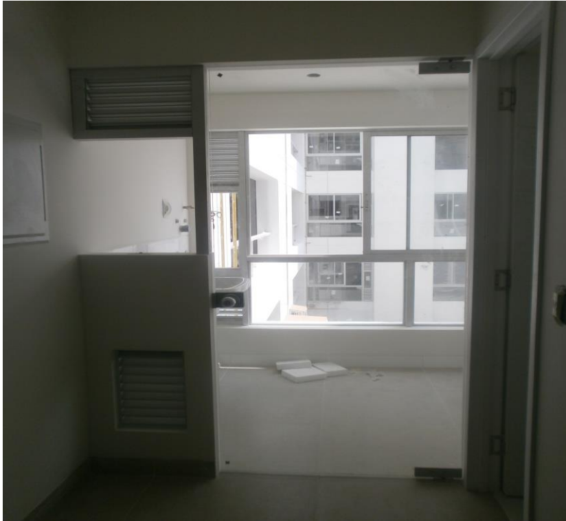
Sistema de ventilación en los departamentos del edificio "Brasil 1" La norma técnica peruana como medida preventiva obliga el uso de rejillas de ventilación si es que este no tiene conexión directa con el exterior.
