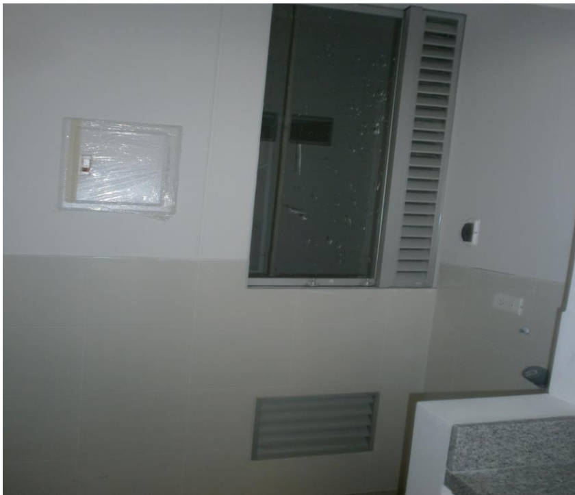
Sistema de ventilación en los departamentos del edificio "Brasil 1" El sistema de ventilación mostrado en la presente figura muestra que en caso de fuga el gas cuenta con comunicación hacia el exterior.
