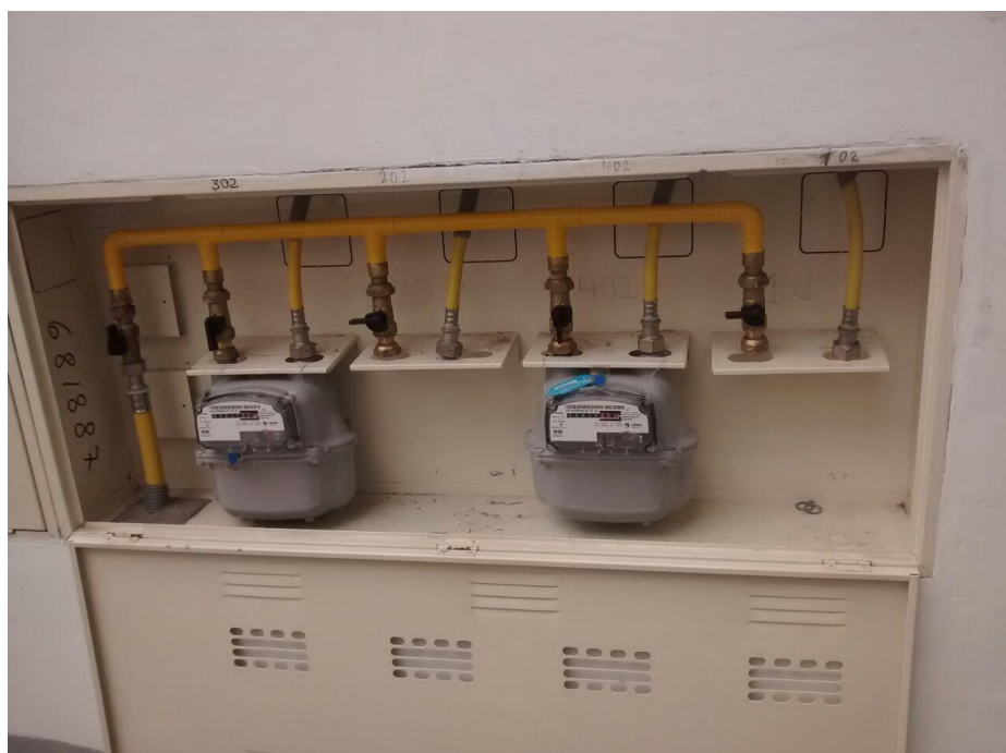
Fotografía de centro de medición abierto Se muestra los medidores de los usuarios que ya cuentan con el servicio de gas natural.
