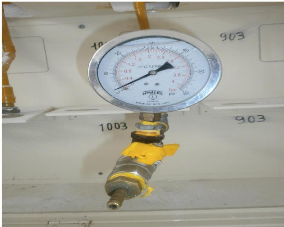
Medición de presión con manómetro.
