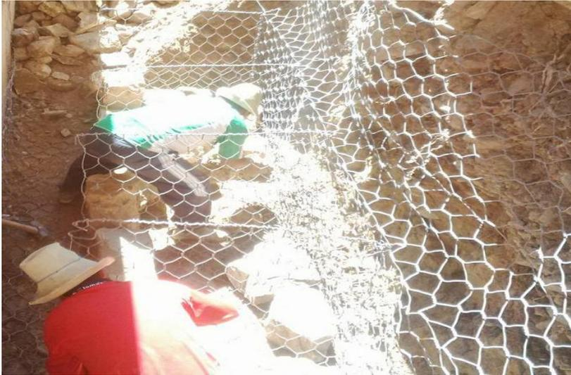
*Figura 16.* Empleo del geotextil gaviones,
