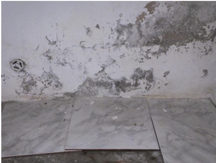
Figura: 3 En esta vista se puede apreciar afloramiento de humedad
