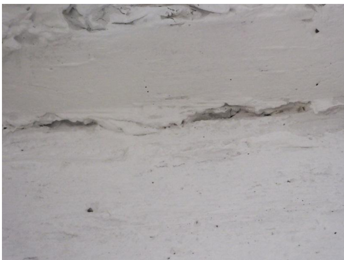
Figura: 4 En la vista se aprecia rajaduras en La pared
