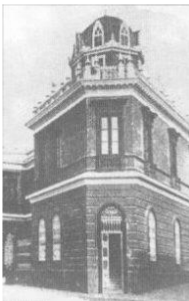
Rancho de 1930 ubicado en la esquina de la avenida Mariscal Castilla y el Malecón de Chorrillos.
