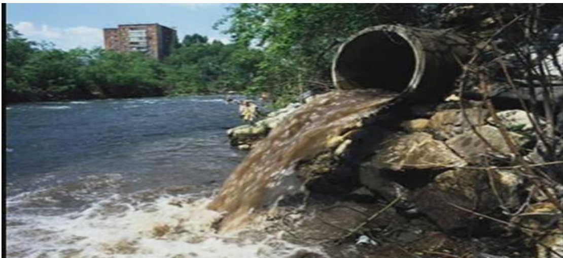
Figura. 9 Tuberías de Las Empresas de Harina que vierten aguas contaminadas
