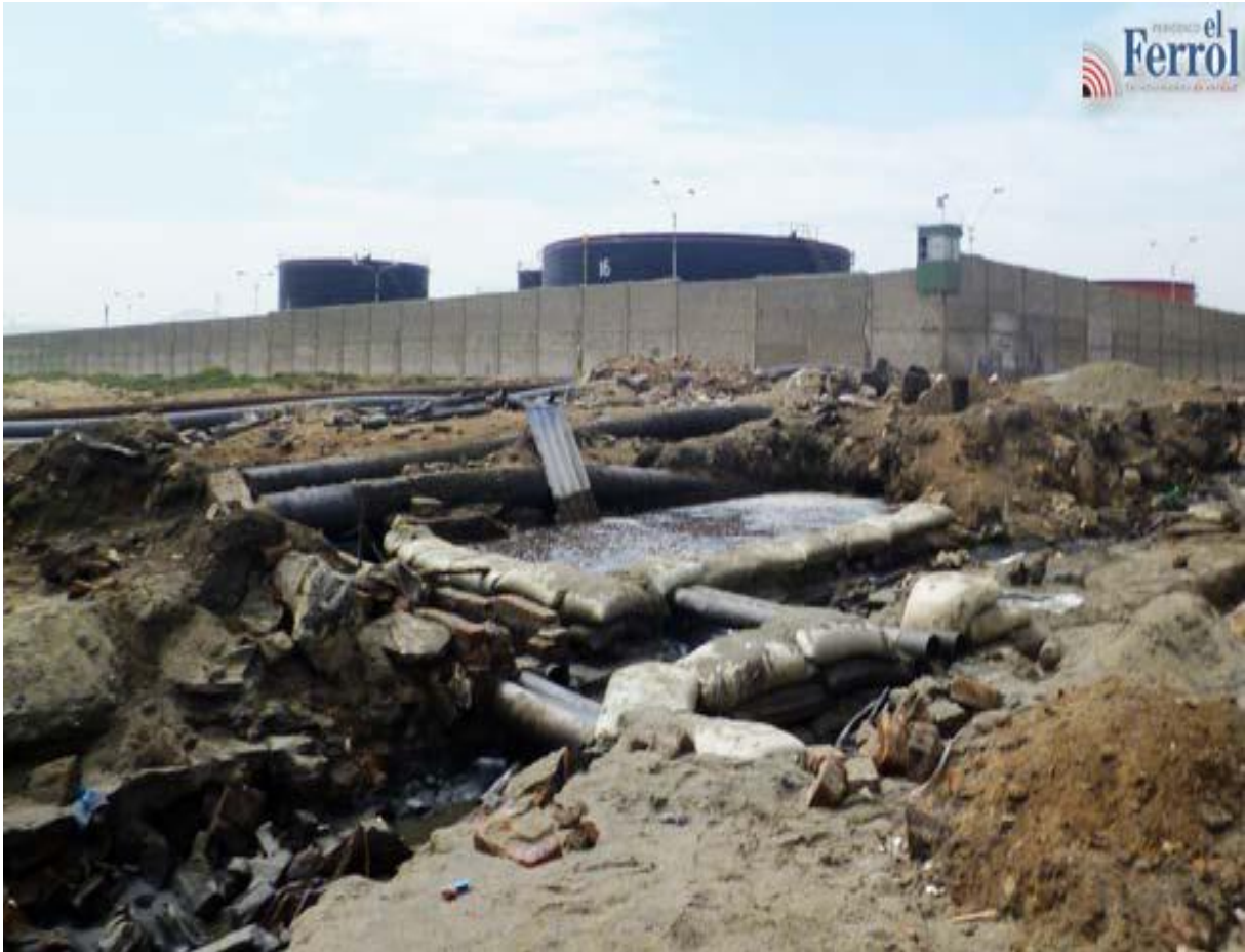
Figura 2 Imagen del deterioro de la bahía del Ferrol
