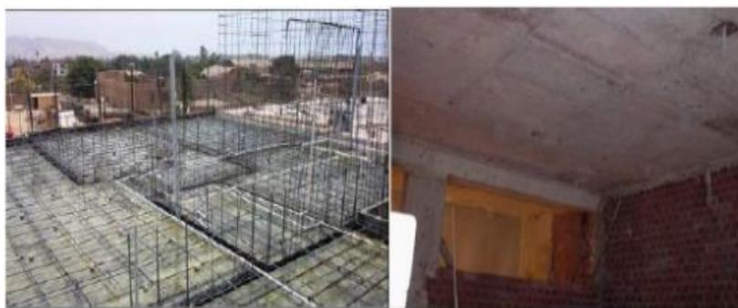
**Figura 11 Losas macizas con muros en sus cuatro bordes.**
