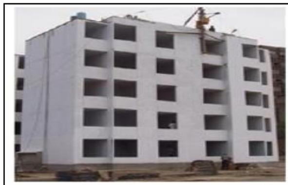
**Figura 13 Sistema estructural de muros resistente en un edificio de viviendas.**
