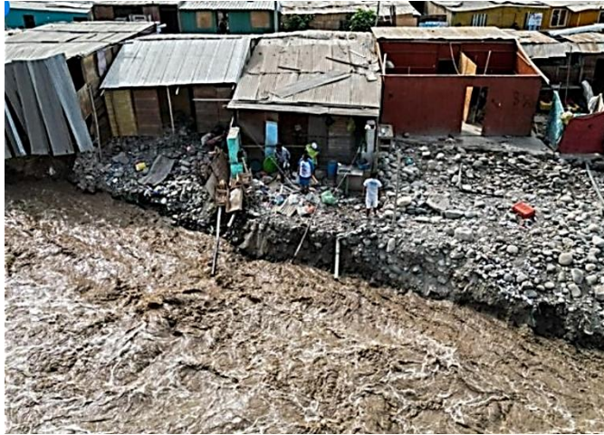
Foto: Tercer tramo: se observa la acumulación de sedimentos que actúan como barreras de desvío hacia los taludes laterales del río generando algunos pequeños deslizamientos.
