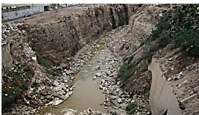
Foto: Vista de surcos en los flancos del río Chillón, se observa bloques caídos por erosión de pie.
