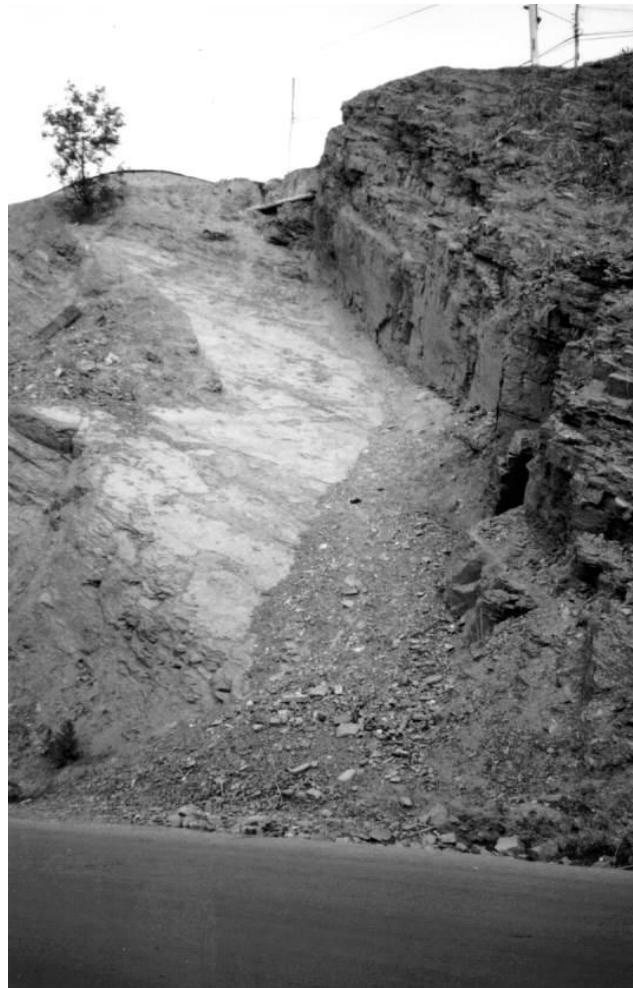
Figura 9. Ruptura de Cuña Fuente: Suárez-Burgoa (2016)
