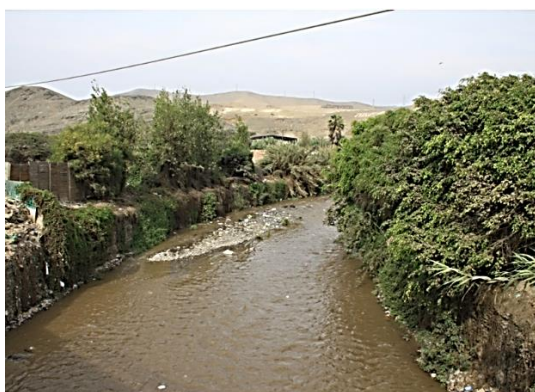
Foto: Vista del primer tramo del río Chillón a la altura de la en él se observa la profundidad de erosión entre 0.50 a 1.50 m. (19) y pequeños deslizamientos a la altura del puente peatonal
