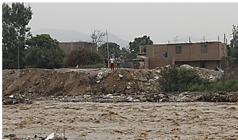
Foto: primer tramo donde se aprecia que los taludes del río Chillón tienen entre 15° y 30° de inclinación.
