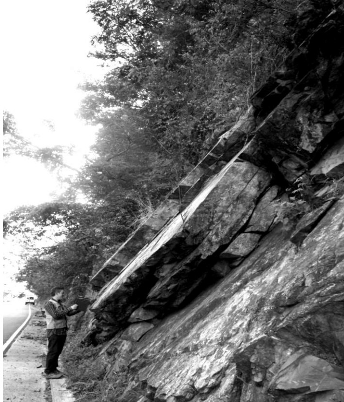
Figura 8. Ruptura plana Fuente: Suárez-Burgoa (2016)
