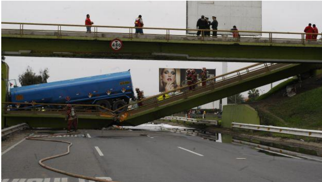
Fuente: El colapso del Puente San Pedro en Lurín.
