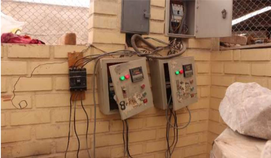
La imagen corresponde al taller de cueros 1, no tiene la señalización de riesgo eléctrico de palancas a pesar que se encuentran abiertas, chuecas y rotas con corrientes sobresalidas, ya que los seres humanos somos conductores de la corriente eléctrica directa o indirecta al estar expuestas a contactos con cables con tensión. En este caso existen cajas defectuosas con riesgo de electrocución fácil de contraer un contacto directo por estar expuesto al alcance humano sin seguridad.
