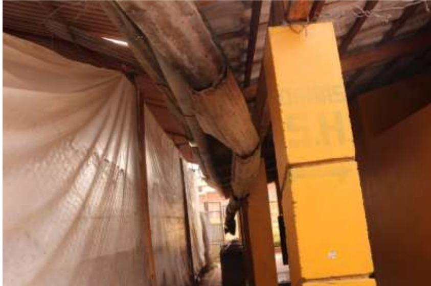
En la fotografía se aprecia las canaletas viejas de techos acondicionados para captación de agua de lluvias en los cilindros para la limpieza de los servicios higiénicos.
