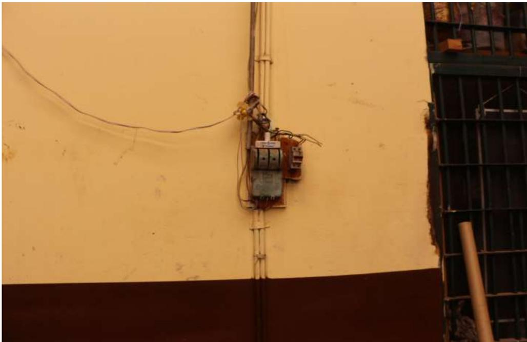
Las exposiciones de generadores eléctricos pueden provocar choque a cajas eléctricas descubiertas, caídas o golpes, roce de cuerpo humano que pueden originar incendios o explosiones de los cables eléctricos al paso provocaría quemaduras, lesiones, fibrilación ventricular hasta la muerte por lo que es necesario las medidas de control y prevención de riesgos eléctricos a través de la renovación del cableado eléctrico entubado y cambio de generadores.
