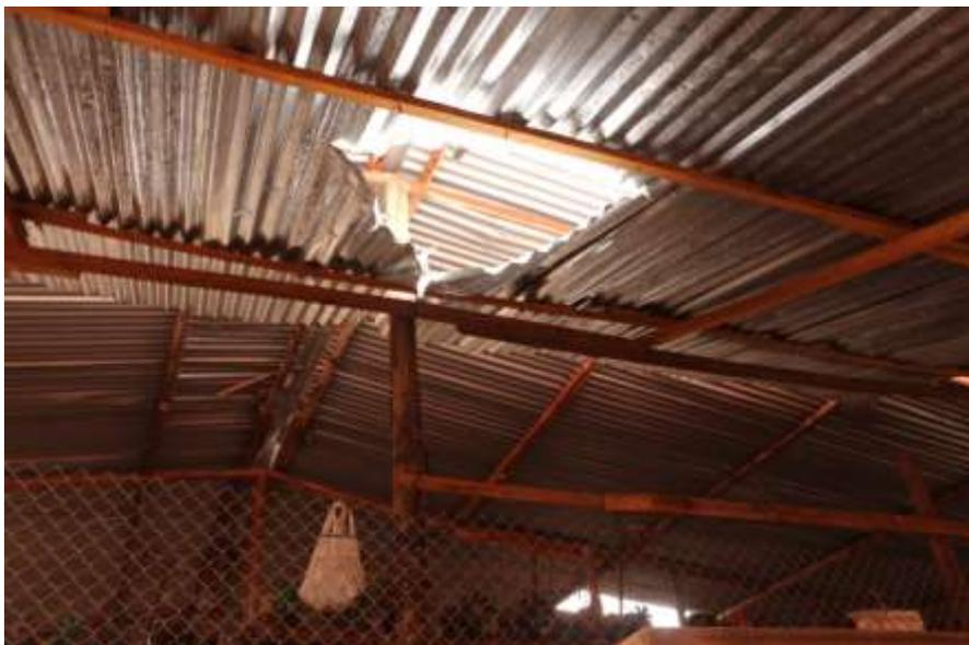
Según la imagen nos muestra una abertura en el techo del taller de telares 1,4 y 5, y se observa los puntos en diferentes partes los cuales han sido parchados con calaminas de segundo uso que no garantiza la seguridad de ingreso de la lluvia o filtración de agua por humedad que pueden generar choque de cortocircuitos por
