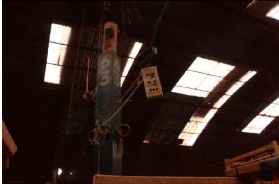
Otra muestra de la negligencia humana son las corrientes o extensiones eléctricas de cables mellizos que no garantizan la alimentación de gran cantidad de carga eléctrica, en el caso de estudio nos permite identificar el factor de riesgo por el uso frecuente de potencia y de alto voltaje en los trabajos de los talleres.
