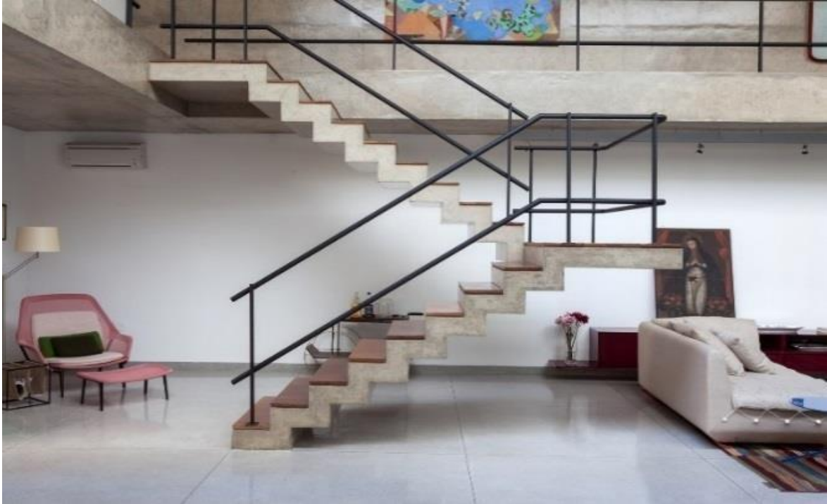
Figura 4. Pasamanos y barandas
