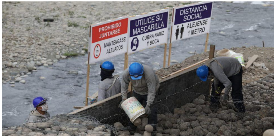
Figura N°4. Construcción de muros de mampostería con gaviones.
