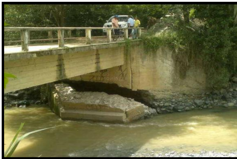
Figura 30. Socavación
