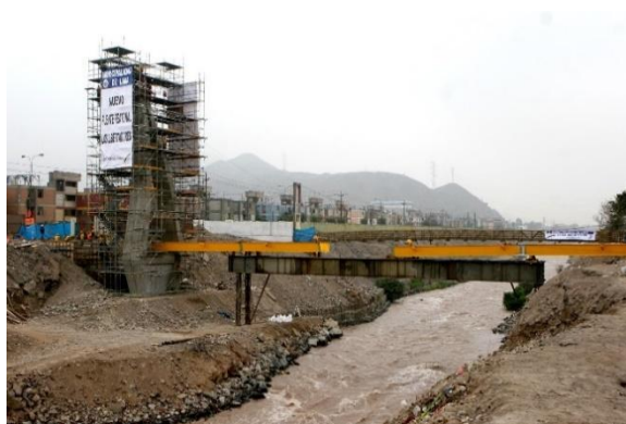
Figura N°2. Construcción con pilotes.
