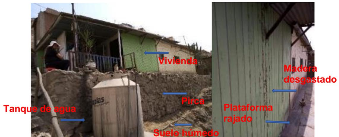
*Figuras 58: Vista exterior de la deficiencia en vivienda de tipología 4*
