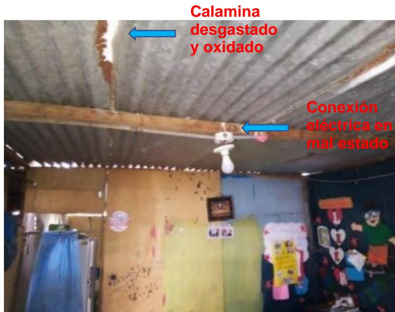
*Figuras 51: Vista interior de la instalación eléctrica*
