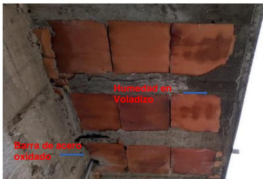
*Figura 64: Vista exterior de la deficiencia en vivienda de tipología 5*
