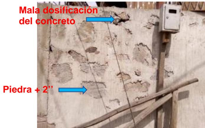
Figuras 54: Vista exterior de la deficiencia en vivienda de tipología 3
