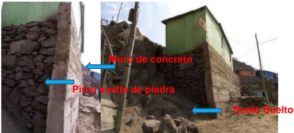
Figuras 46: Vista exterior de los muros y estructura de la vivienda
