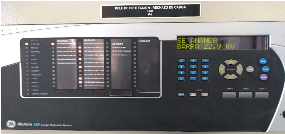
Relé Protección Rechazo Carga – GE F60 – F4.
