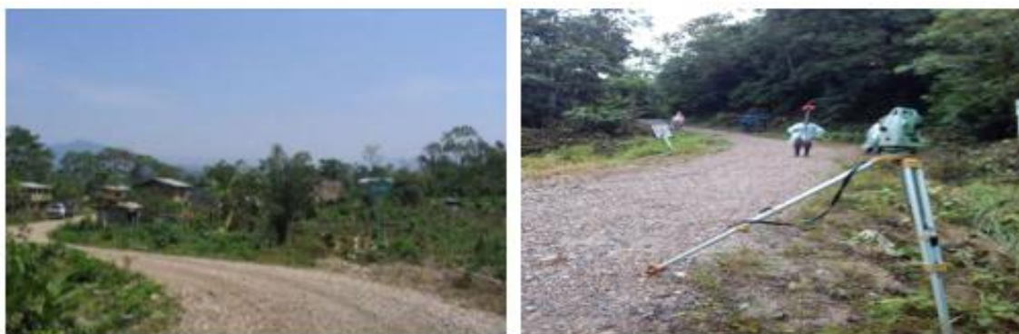
Figura 5. Camino carrozable de la carretera Federico Basadre km 108 - Valle Sagrado – Alto Aguaytillo, Distrito de Irazola, provincia Padre Abad
