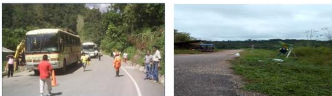
Figura 4. Tramo asfaltado y carrozables de la carretera Federico Basadre, sector Boquerón
