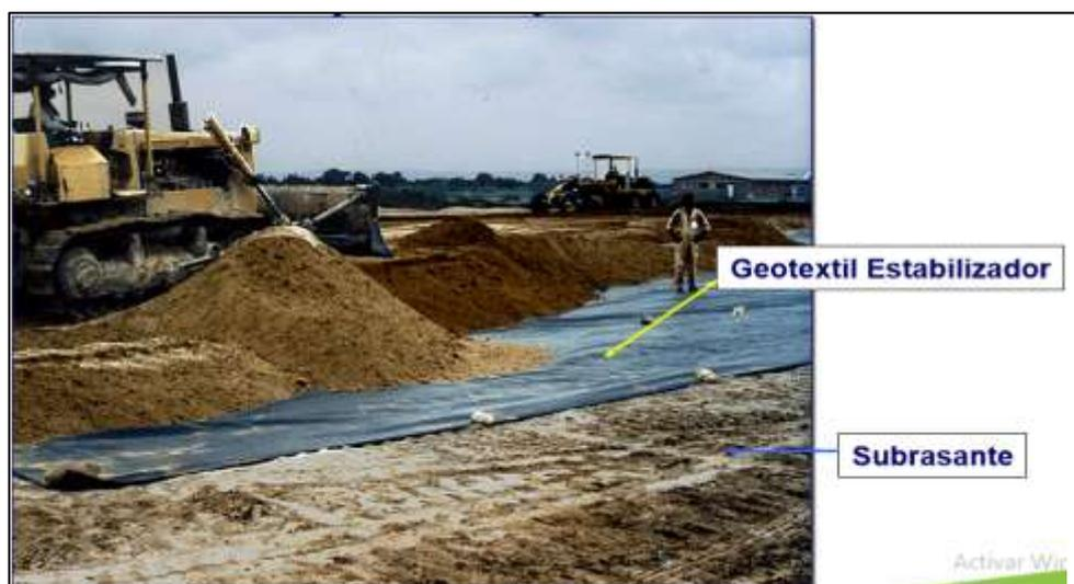
**Figura 8.** Geotextil Estabilizador.
