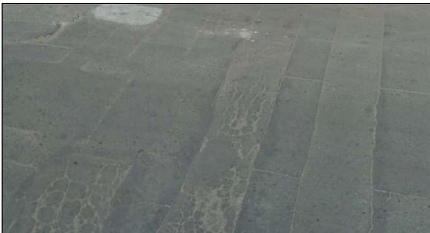
Falla, Piel de cocodrilo severo causado por fatiga del pavimento, parcheo de forma longitudinal y transversal, a lo largo de toda la Av. Los Laureles se aprecian peladuras.
