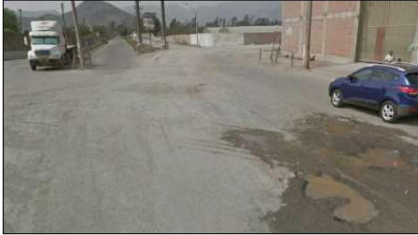
Av. Los Laureles con Av. Quinta presenta fallas como baches severos, desgaste y destrucción de la vía de forma que no se aprecia el asfalto en la intersección.
