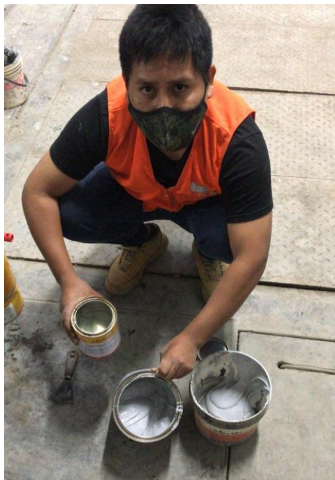
Figura 45: mezclado de epòxico para el pegado de la fibra de carbono Fuente: elaboración propia
