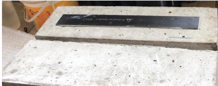
Figura 51: aplicación de SIKA CARBODUR s512 en viga Fuente: elaboración propia
