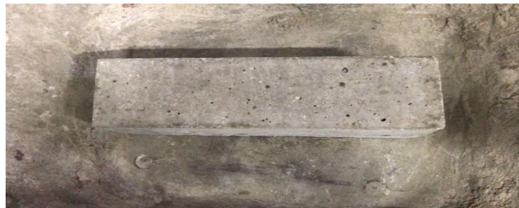
Figura 50: lijado y limpieza de superficie de viga
