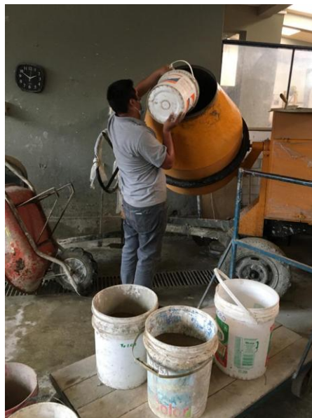
Figura 35: vaciado de agregado al trompo para elaboración del concreto Fuente: elaboración propia
