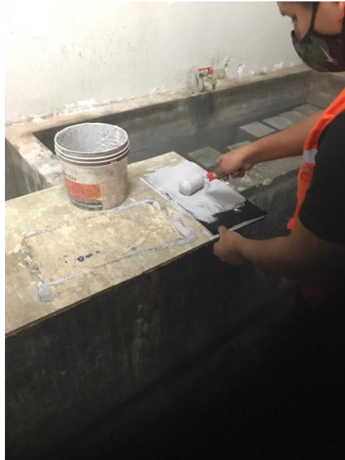
Figura 47: aplicación del epòxico sobre el tejido para su adherencia Fuente: elaboración propia
