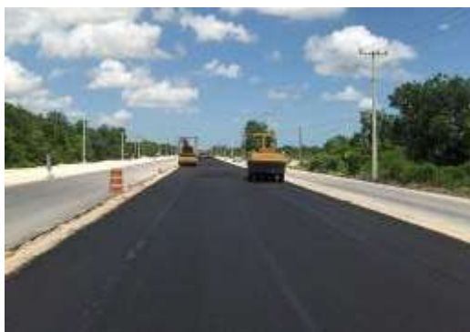
Figura 1: Infraestructura vial urbana
