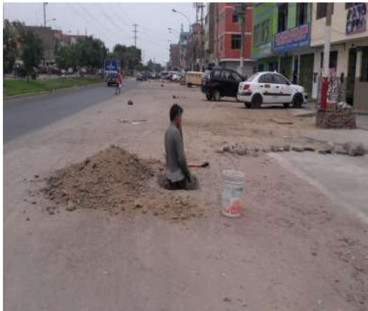
Figura 12. Excavación de calicata 4 - muestra
