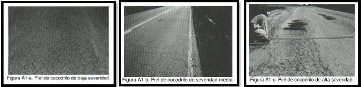
Figura 5. Piel de Cocodrilo Nivel de Severidad (A) Baja, (B) Media, (C) Alta. Fuente: Pavement Condition Index (PCI) , (2002).
