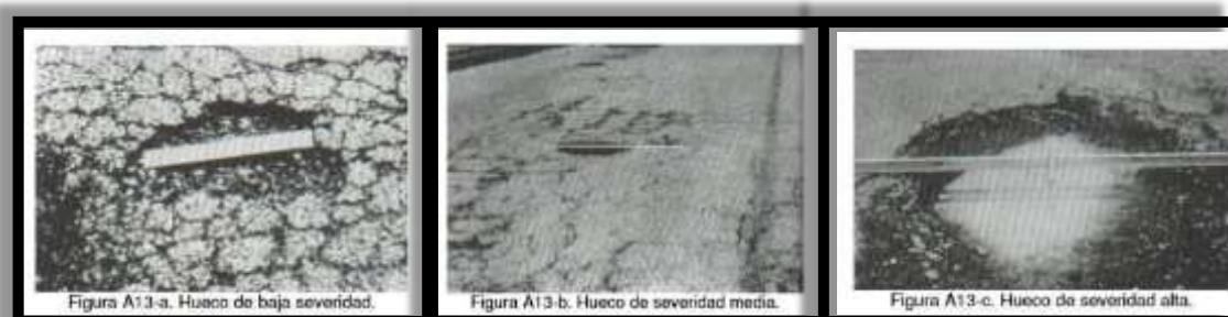
Figura 15. Huecos Nivel de Severidad (A) Baja, (B) Media, (C) Alta.
