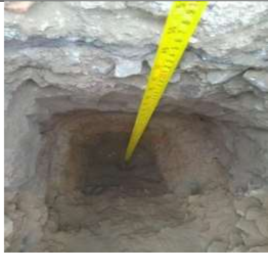
Figura 6. Fondo de Calicata - 3
