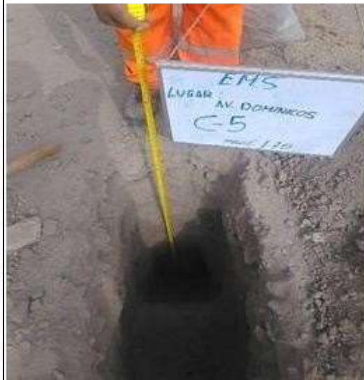
Figura 8. Fondo de Calicata - 5
