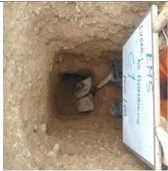
Figura 2. Fondo de Calicata- 1
