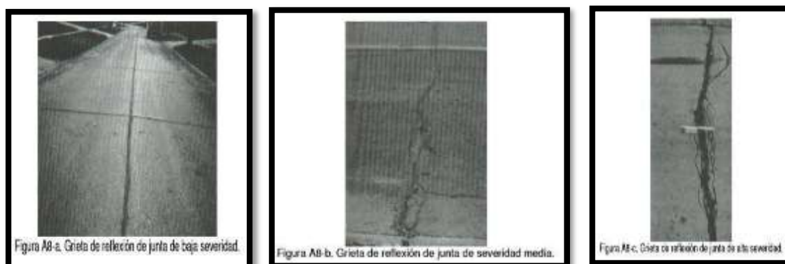
Figura 12. Grieta de Reflexión e Junta Nivel de Severidad (A) Baja, (B) Media, Fuente: Pavement Condition Index (PCI), (2002).
