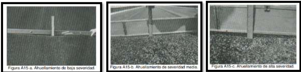
Figura 17. Ahuellamiento Nivel de Severidad (A) Baja, (B) Media, (C) Alta. Fuente: Pavement Condition Index (PCI) , (2002).
