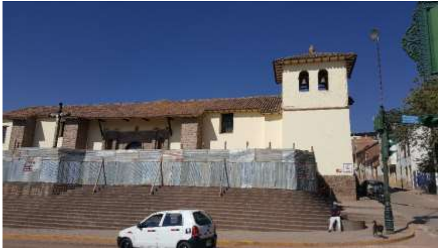
Figura 60. Estado actual de la obra en ejecución
