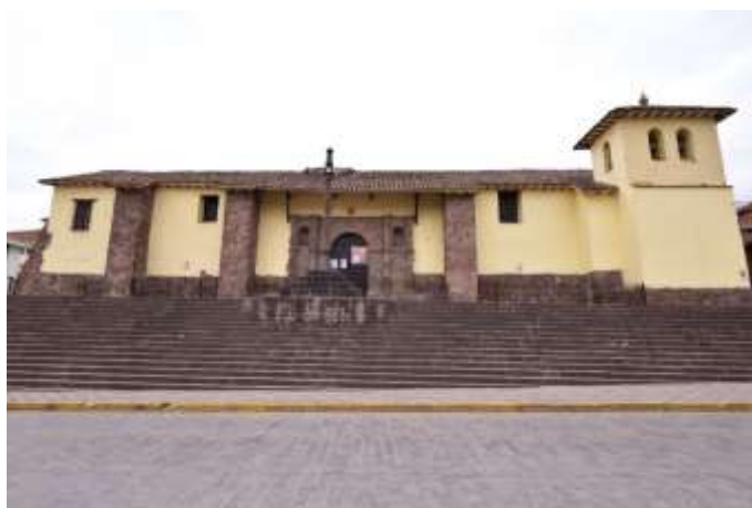
Figura 19. Fachada de la Iglesia Santiago
