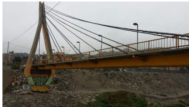
Puente peatonal Solidaridad
