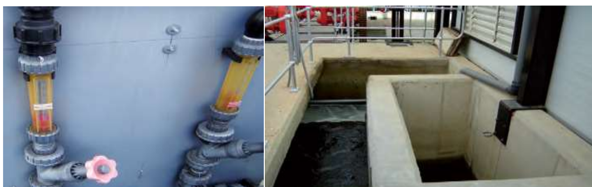
Figura 4: Floculación Fuentes: (Junta de Castilla y León, 2016) Manual de tratamientos del agua de consumo humano
