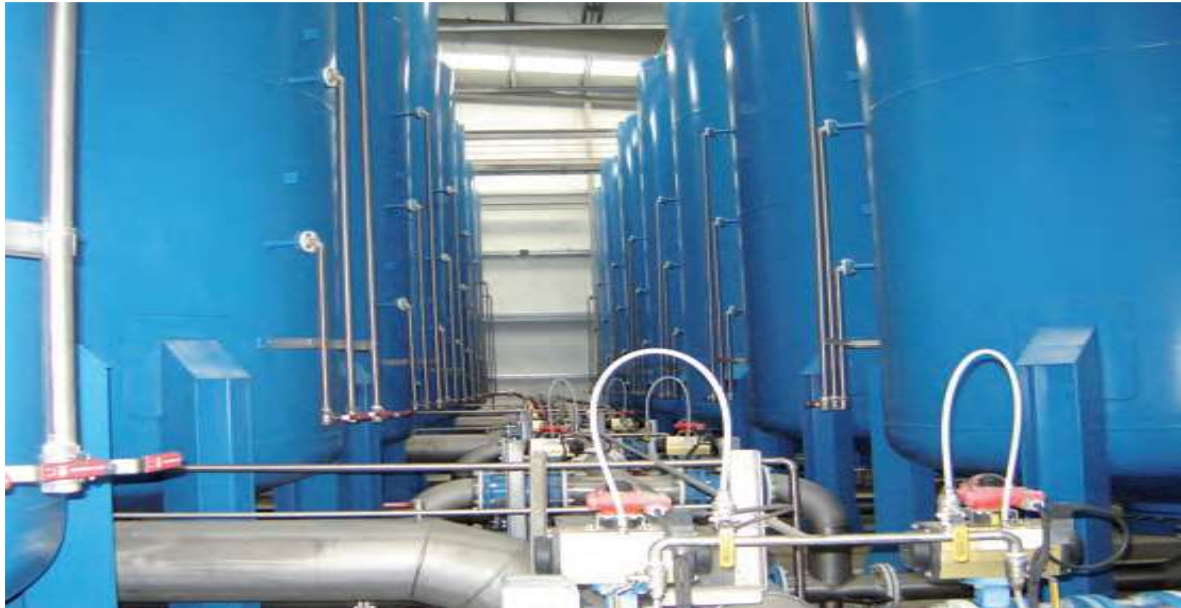
Figura 7: Filtración con carbón activo Fuentes: (Junta de Castilla y León, 2016) Manual de tratamientos del agua de consumo humano
