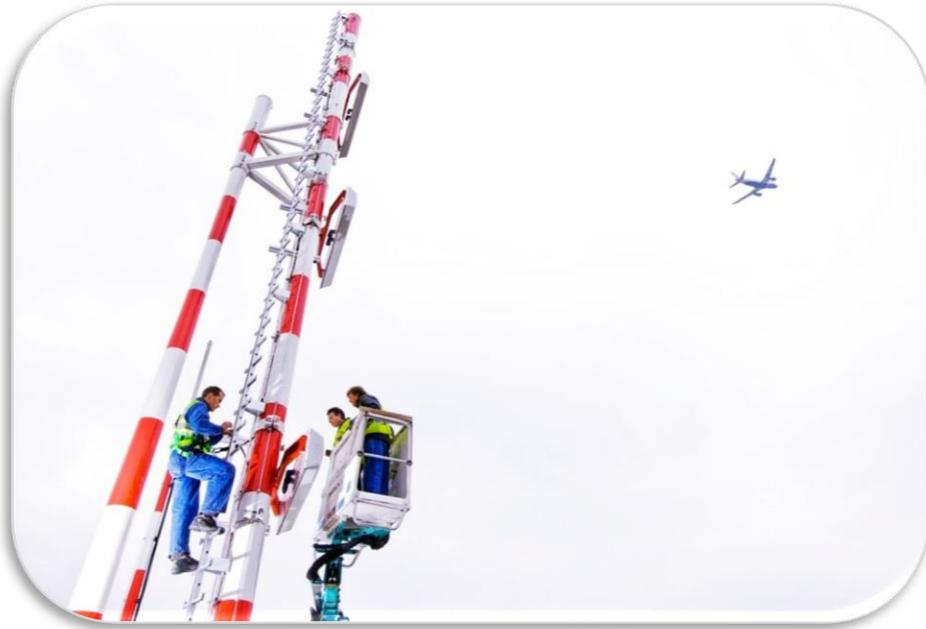
Figura 43. Antena de soporte para cámara 2 de seguimiento de vigilancia ubicada en equipos REDAP, para visualización de Plataforma SUR y últimos 1500 Mts. De pista aterrizaje.
