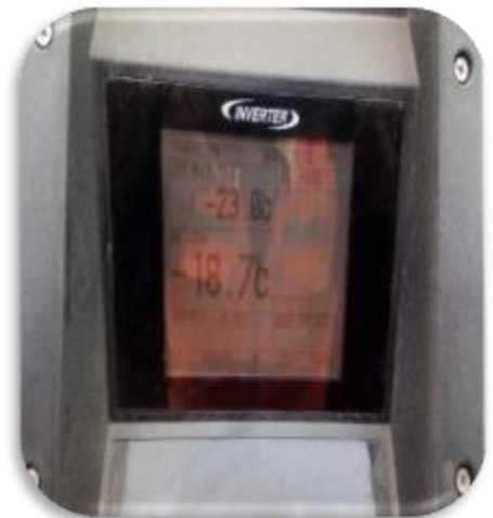
SALIDA CONTENEDOR - 18º GRADOS.
