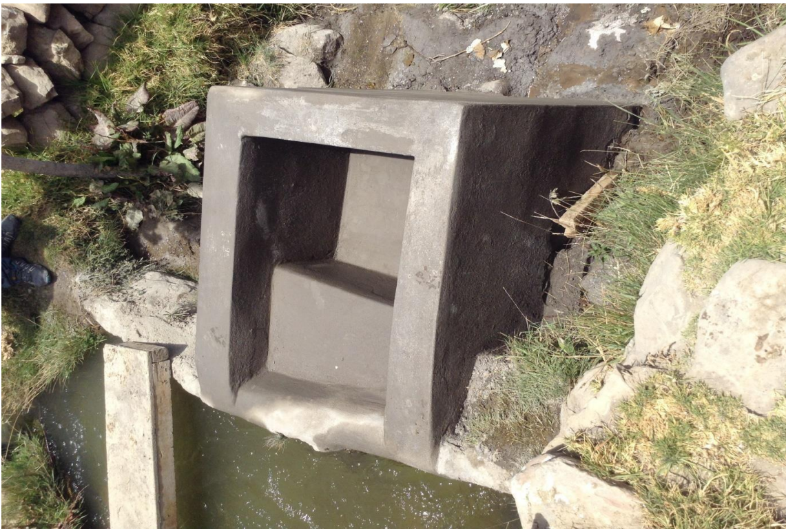
Figura D. Captación de agua en quebrada de Lluta.
