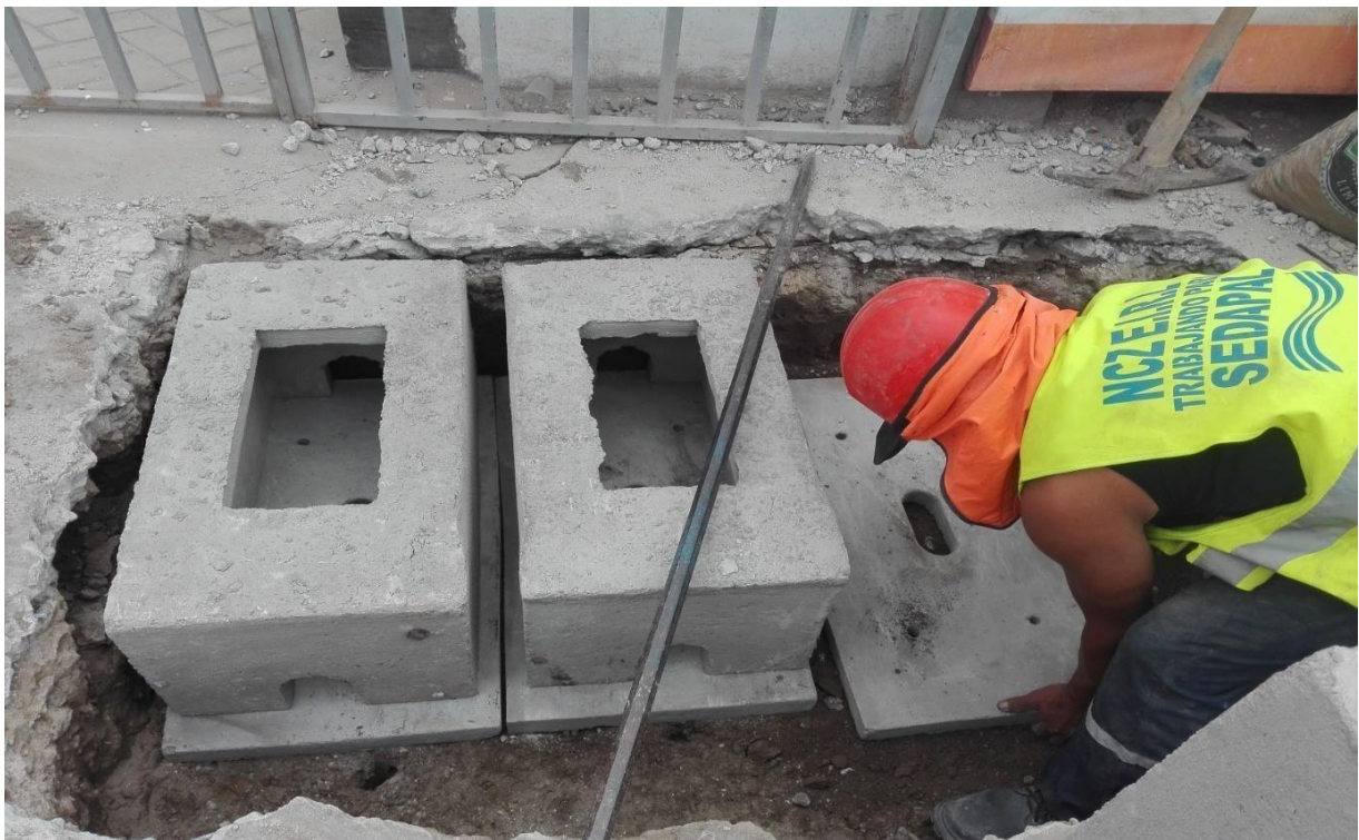
Figura M. Instalación de cajas pre fabricadas de agua potable con la contratista NCZ.
