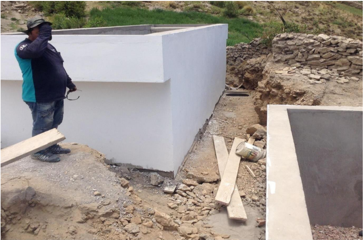
Figura H. Vista externa de camarra de agua potable en Lluta.
