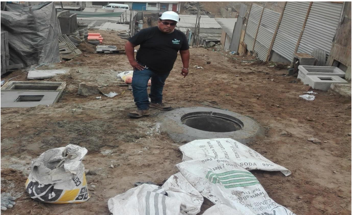
Figura K. Verificando los acabados de buzones y buzonetas más conexiones domiciliarias.
