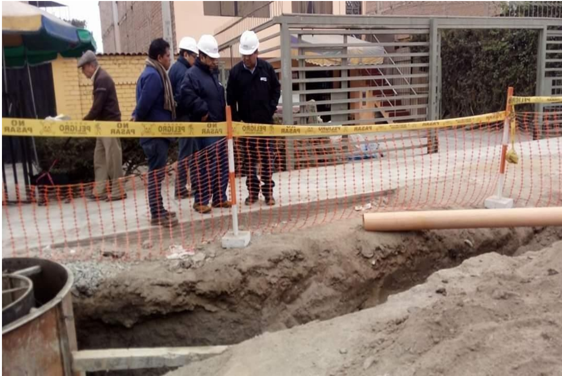
Figura C. Verificando con la supervisión las redes de agua potable.
