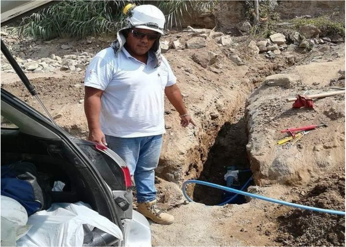
Figura J. Realizando pruebas hidráulicas para redes de agua potable
