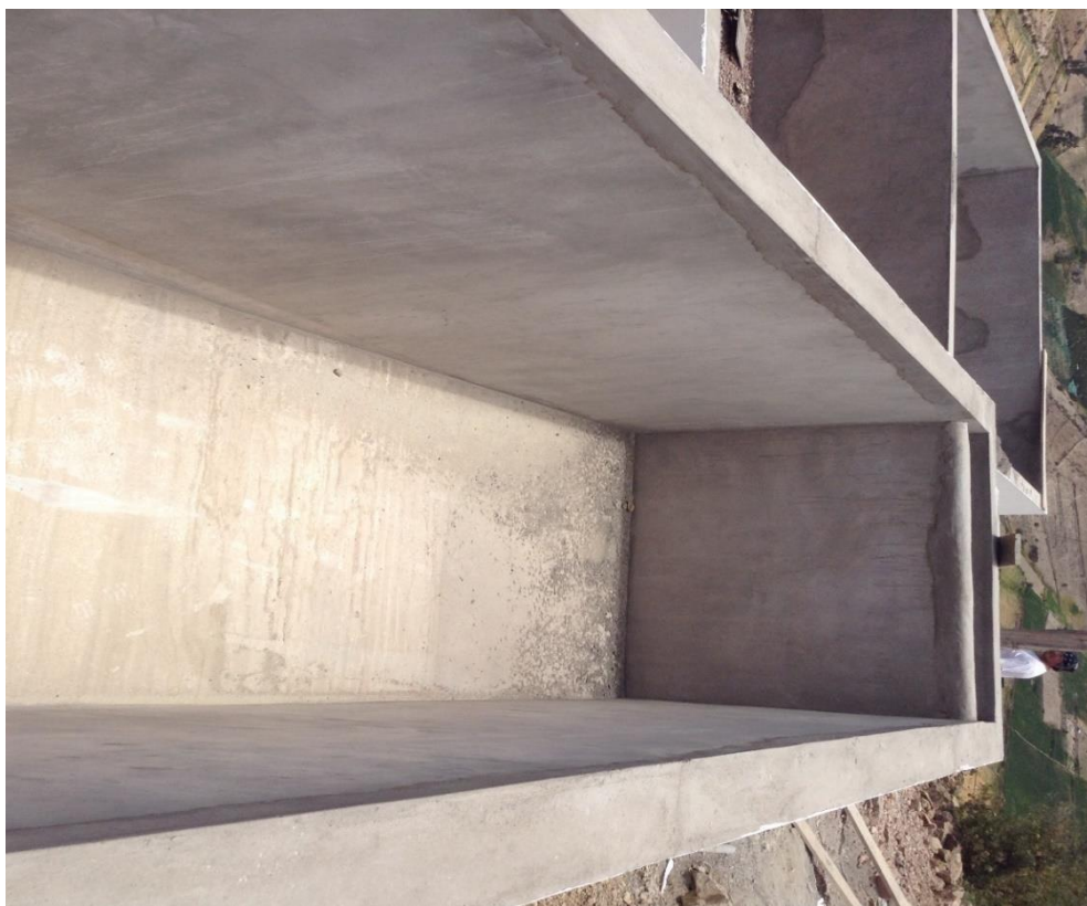
Figura 7: Reservorio apoyados en Lluta
