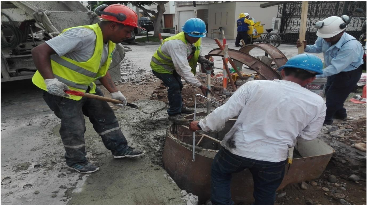
Figura L. Llenado de buzón con concreto.
