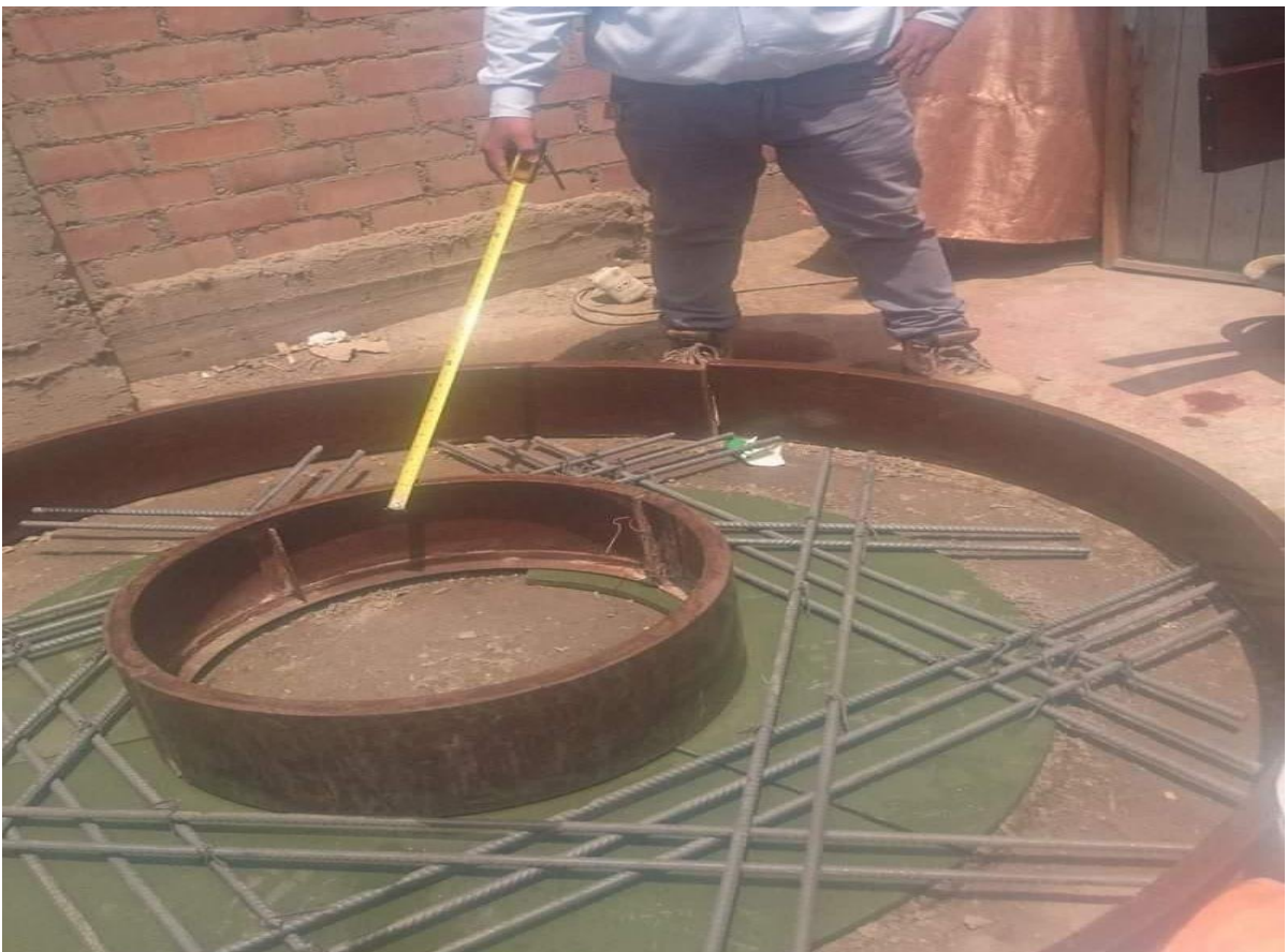
Figura I. Estructura de techo de buzón para su próximo llenado de concreto.
