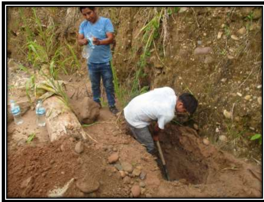
SE MUESTRA AL PERSONAL REALIZADO CALICATAS EN LOS ESTRIBOS.
