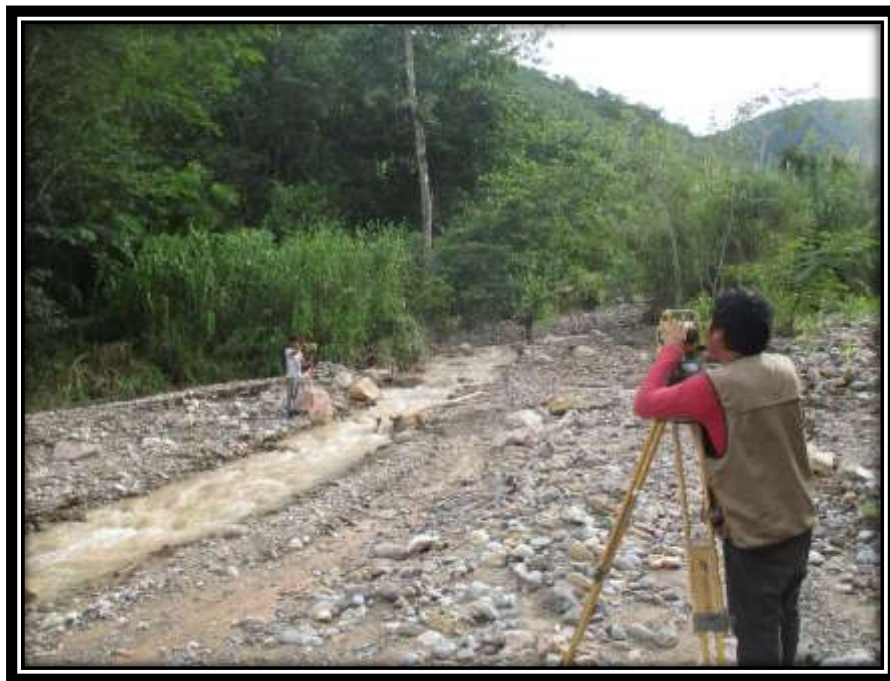
SE APRECIA LOS TRABAJOS DE LEVANTAMIENTO TOPOGRÁFICO EN EL LECHO DEL RIO
