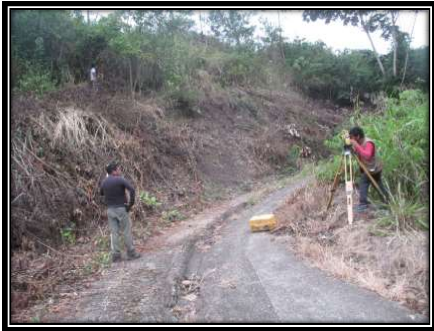
SE MUESTRA EN LA FOTOGRAFÍA EL TRABAJO DE LEVANTAMIENTO TOPOGRÁFICO.
