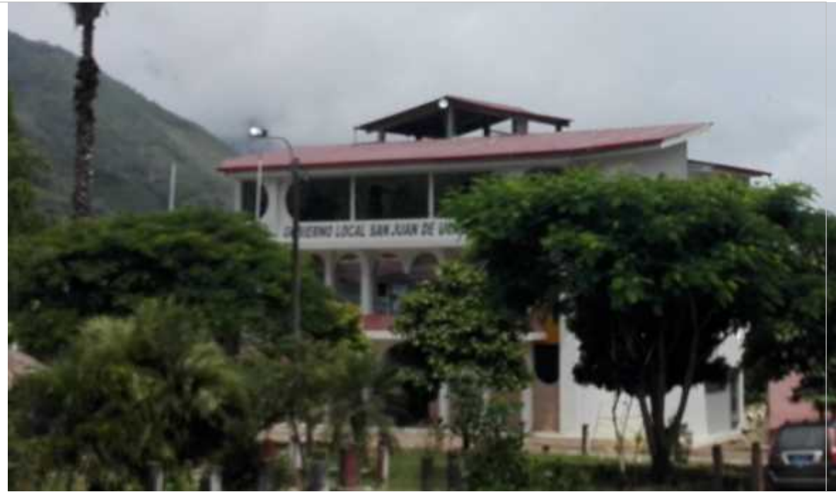
Figura 30: Antena Instalada en local Municipal de San Juan de Uchubamba.
