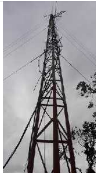
Figura 14: Torre de Comunicación.
