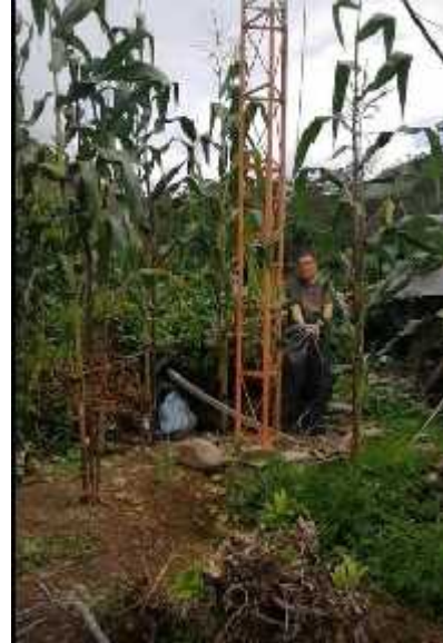
Figura 16: Traslado cable de red a la Torre.
