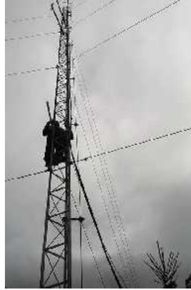
Figura 23: Instalando la Antena Omnidireccional en Torre.
