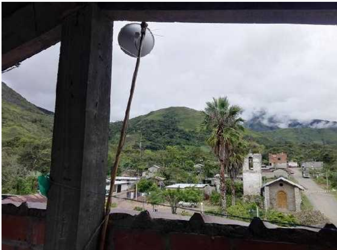
Figura 29: Antena Instalada en local Municipal de San Juan de Uchubamba.
