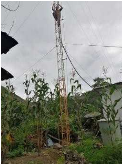
Figura 24: Asegurando Antena Omnidireccional.
