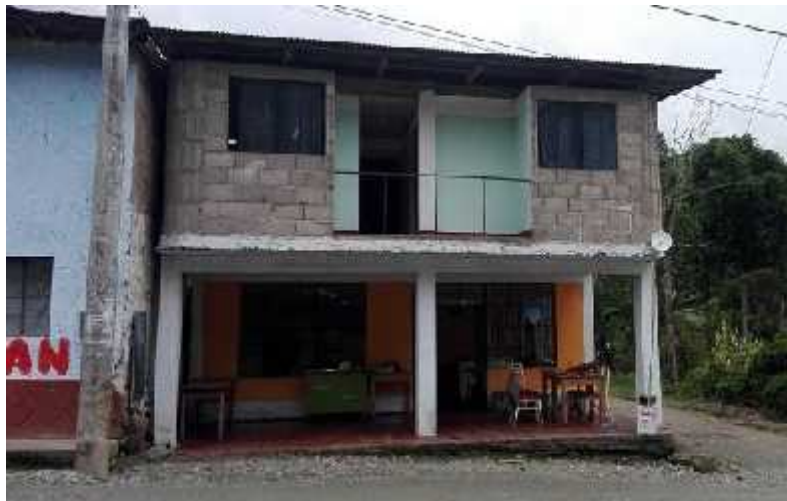
Figura 27: Antena instalada en Restaurant.
