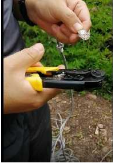
Figura 15: Colocando Conectores RJ45 cat 6.
