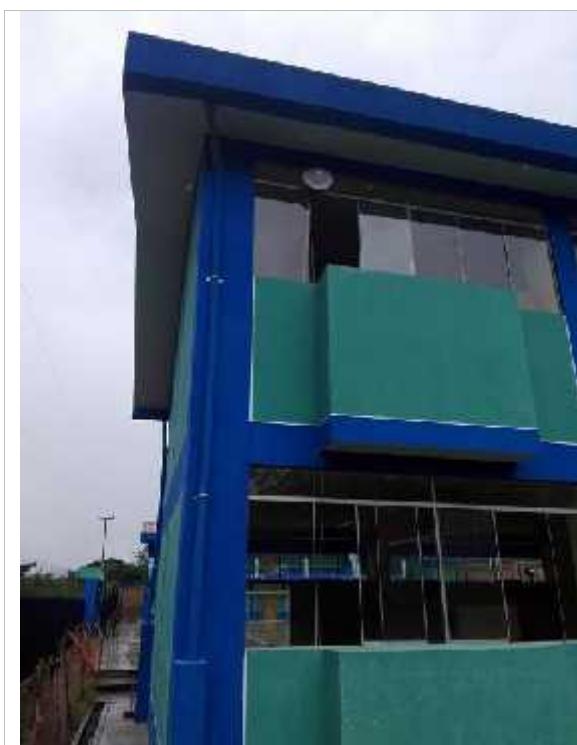
Figura 32: Antena Instalada en Centro Educativo.
